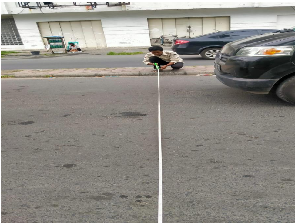
Gambar L.1.3: Proses Pengukuran Lebar Jalan
