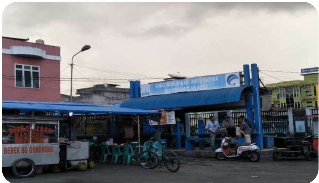
Kondisi Halte Terminal Angkutan Tipe B di Terminal Desa Blang Mersah
