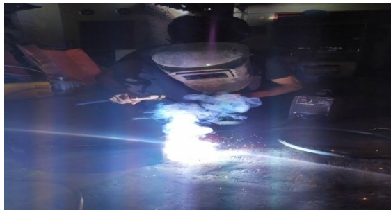
Gambar 3.32. Menghubungkan Benda Kerja
