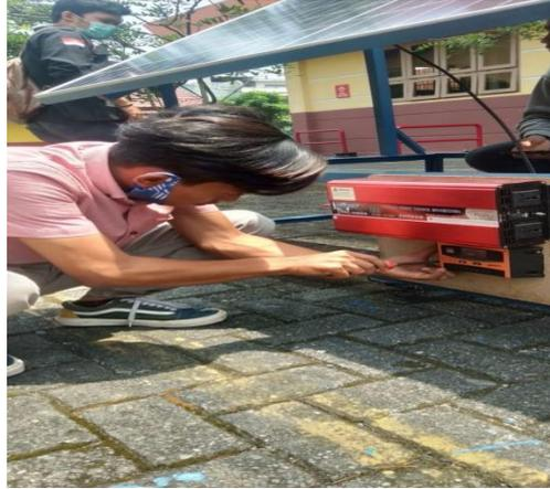
Gambar 3.20 Pemasangan *Charger Controller*
