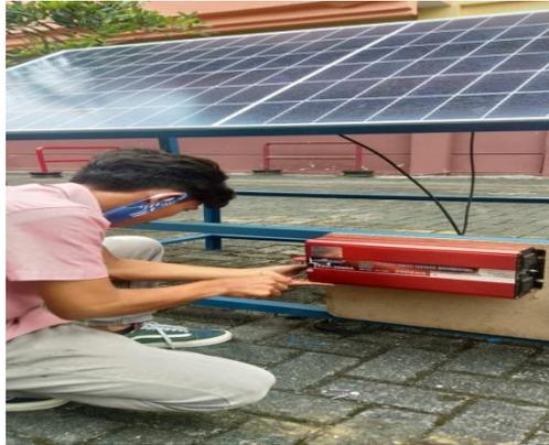
Gambar 3.21 Pemasangan Inverter
