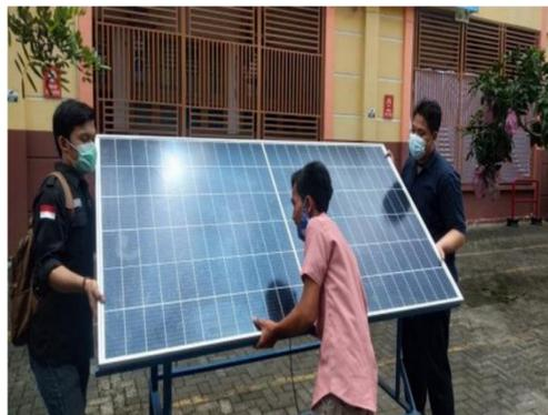
Gambar 3.19 Pemasangan Panel Surya Pada Sudut  $40^{\circ}$
