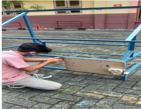
Gambar 3.17 Pemasangan Papan Dudukan Komponen Sel Surya
