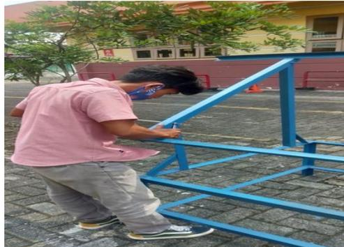
Gambar 3.18 Pemasangan Tiang Penyangga Dudukan Panel Surya
