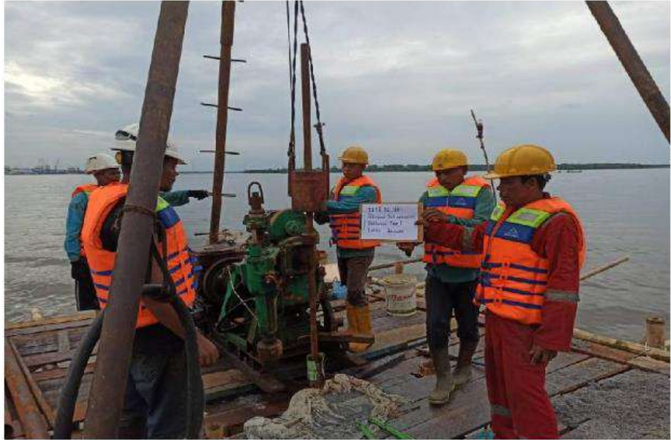
Pekerjaan Bore Mesin BH - 1 (Laut )
