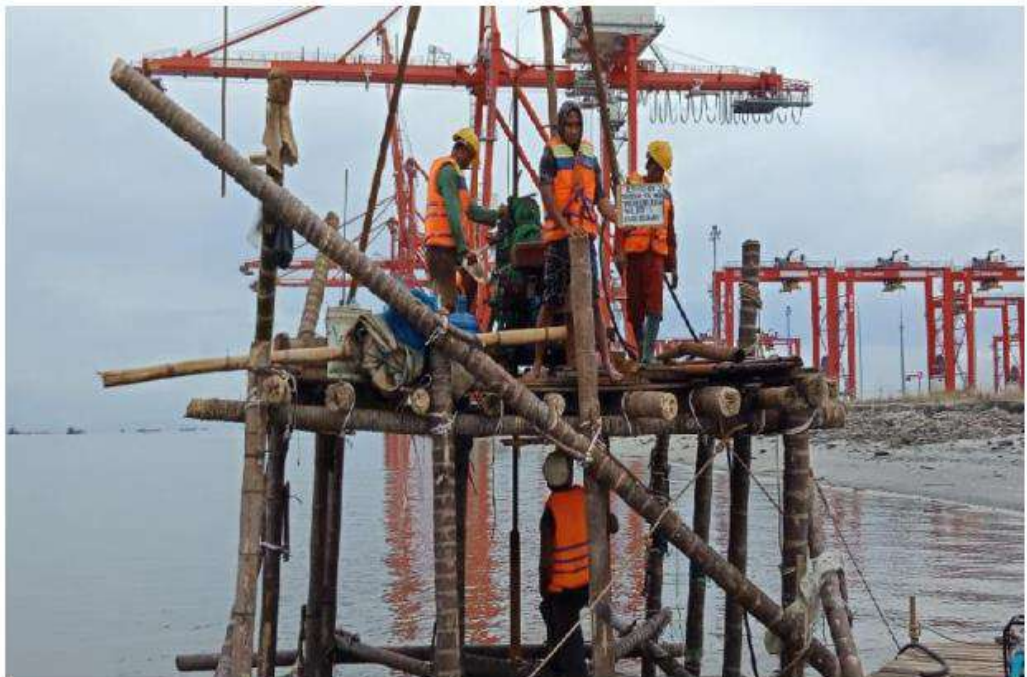
Pekerjaan Bore Mesin BH - 2 (Laut )
