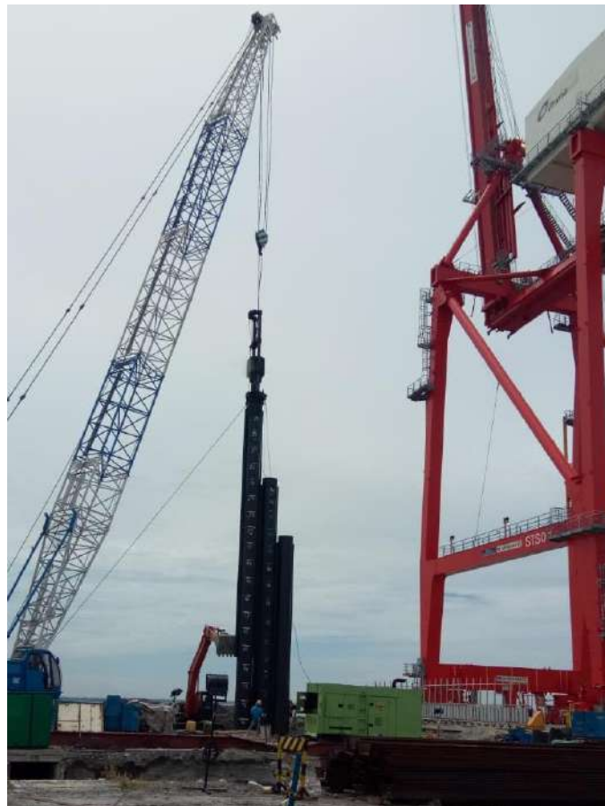
Pemancangan Sheet Pile
