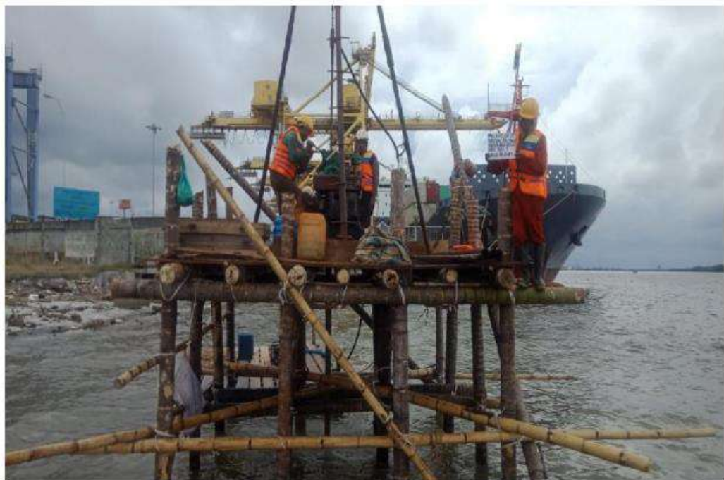
Pekerjaan Bore Mesin BH - 4 (Laut )
