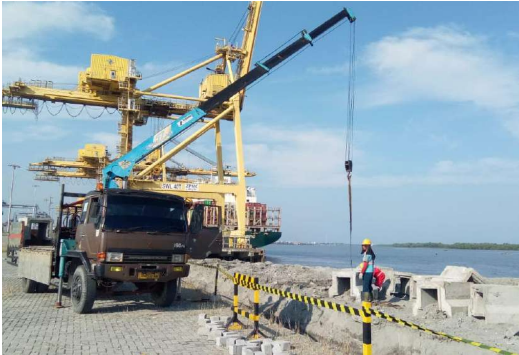
Pembongkaran Drainase Eksisting
