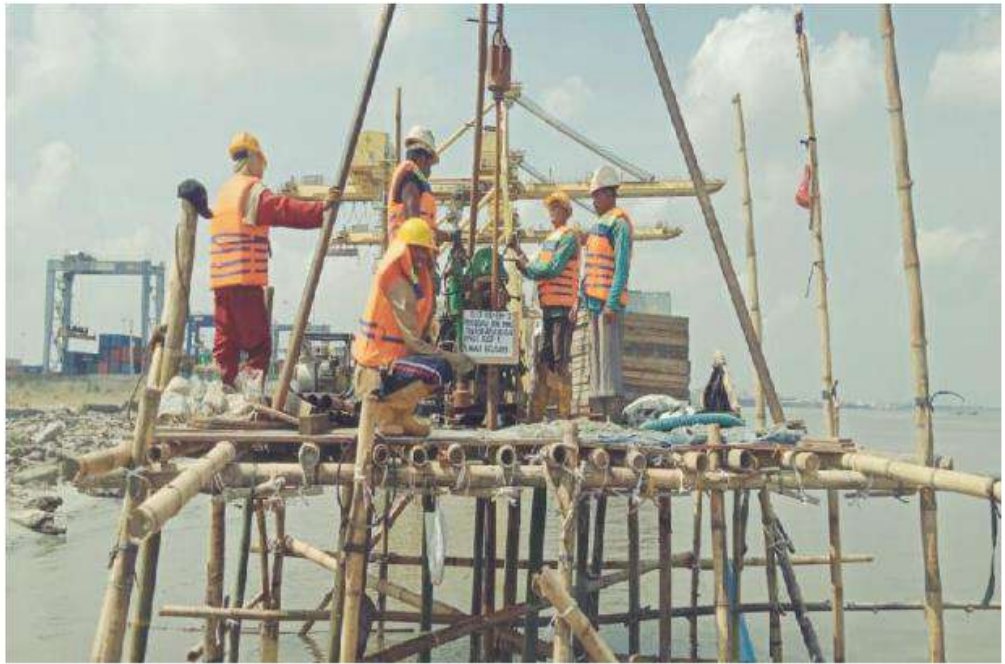
Pekerjaan Bore Mesin BH - 3 (Laut )
