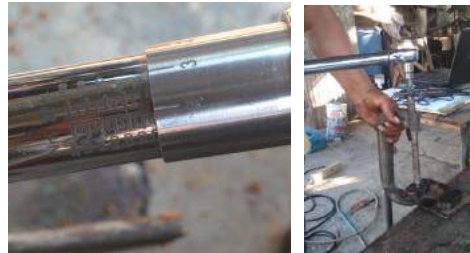
Gambar 3.7 Penekanan Dengan Kunci Torsi
