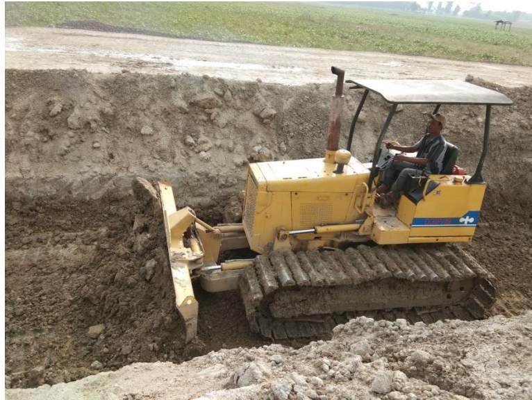
Gambar L.2: Pekerjaan Tanah Stripping yang dilakukan alat berat Dozer
