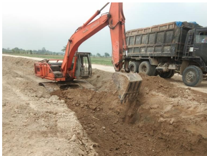
Gambar L.1: Excavator yang sedang melakukan Pekerjaan Tanah galian sekaligus memindahkan hasil galiannya ke dump truck
