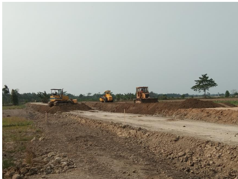
Gambar L.3: Pekerjaan Perataan tanah yang dilakukan Dozer , sekaligus Pematatan tanah yang dilakukan Compactor .
