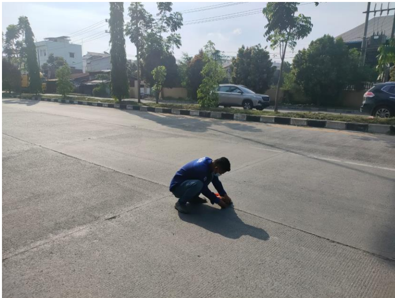
Gambar L.6: Pengukuran Kerusakan Jalan
