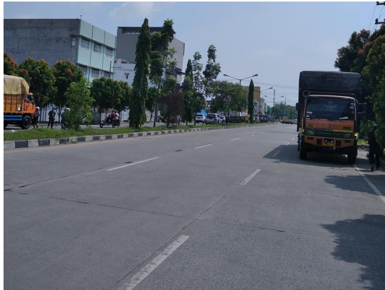
Gambar 4.5: Kondisi Jalan Cemara
