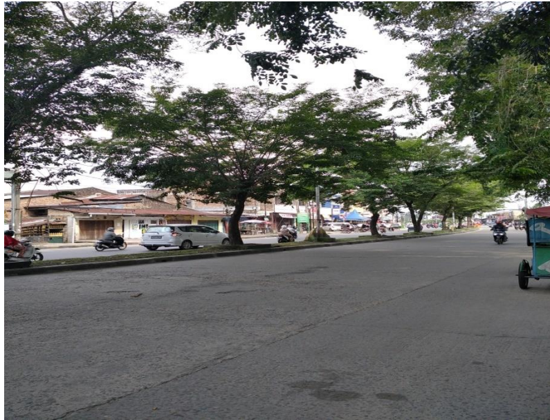
Gambar L.1: Kondisi Jalan Sisingamanga Raja
