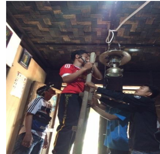
Gambar 6. 9 Pemasangan Sistem Distribusi di Bintang Asih
