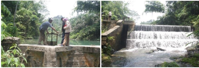
Gambar 2. 4 Bendungan yang di manfaatkan sebagai PLTMH
