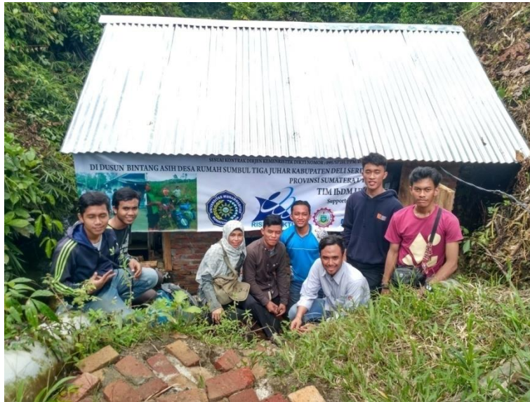
Gambar 7.3 Power House PLTMH Bintang Asih
