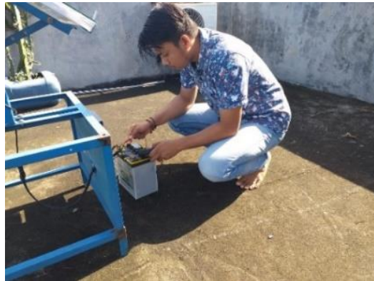
Gambar 3.24 Pemasangan baterai dan kabel-kabel penghubung
