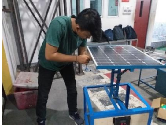
Gambar 3.23 Pemasangan panel surya
