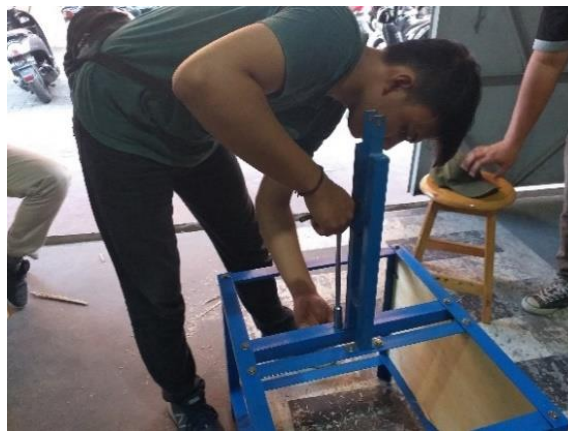
Gambar 3.22 Pemasangan pengangga panel
