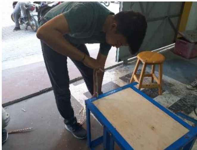
Gambar 3.19 Pemasangan Triplek
