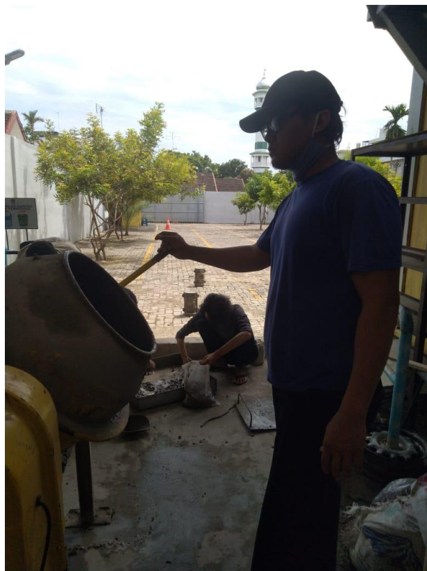
Gambar L4: Dokumentasi proses pengecoran pembuatan benda uji penelitian
