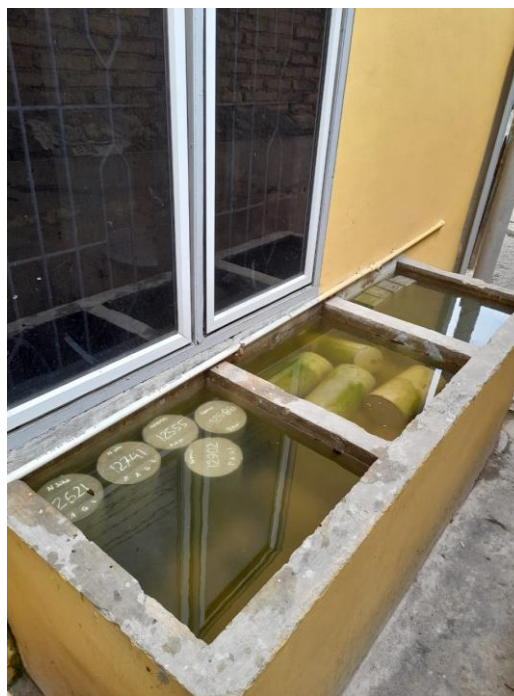
Gambar L8: Dokumentasi proses perawatan beton
