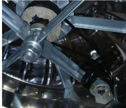
Gambar 3.13 Menghubungkan shaft turbin dengan shaft motor
