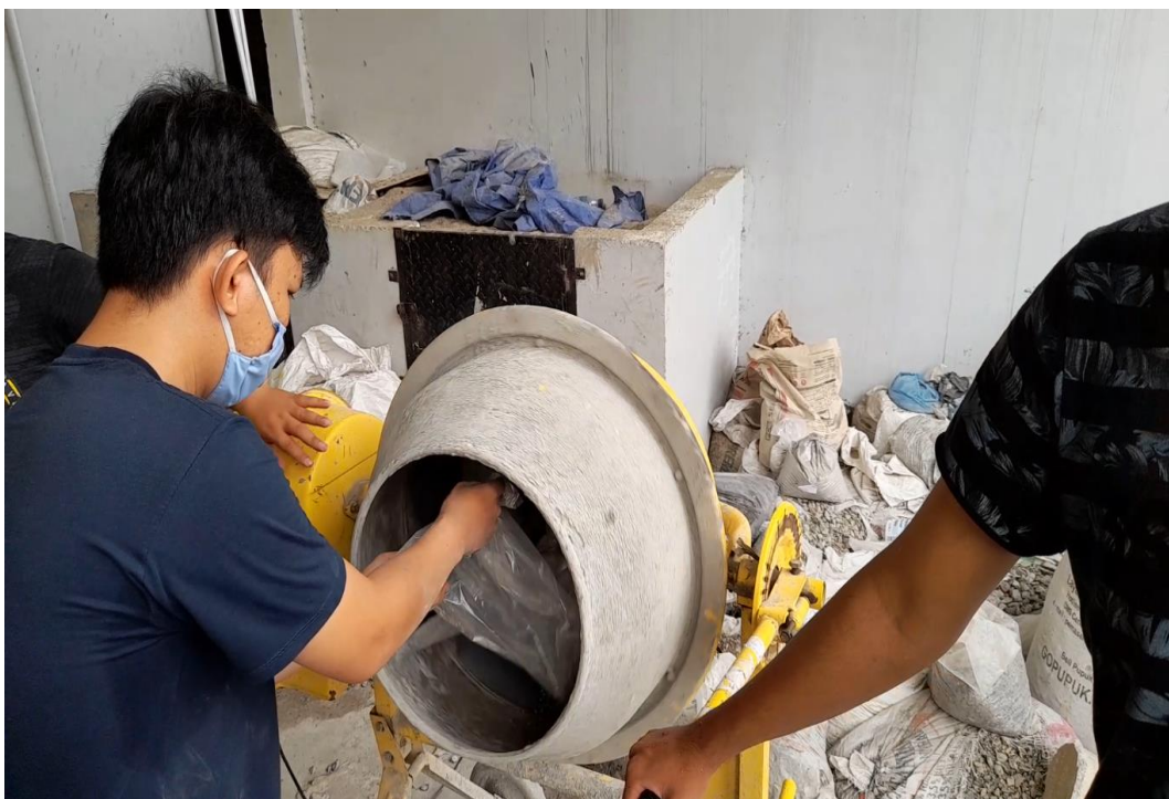
Gambar L-18: Proses Pembuatan Adukan Beton
