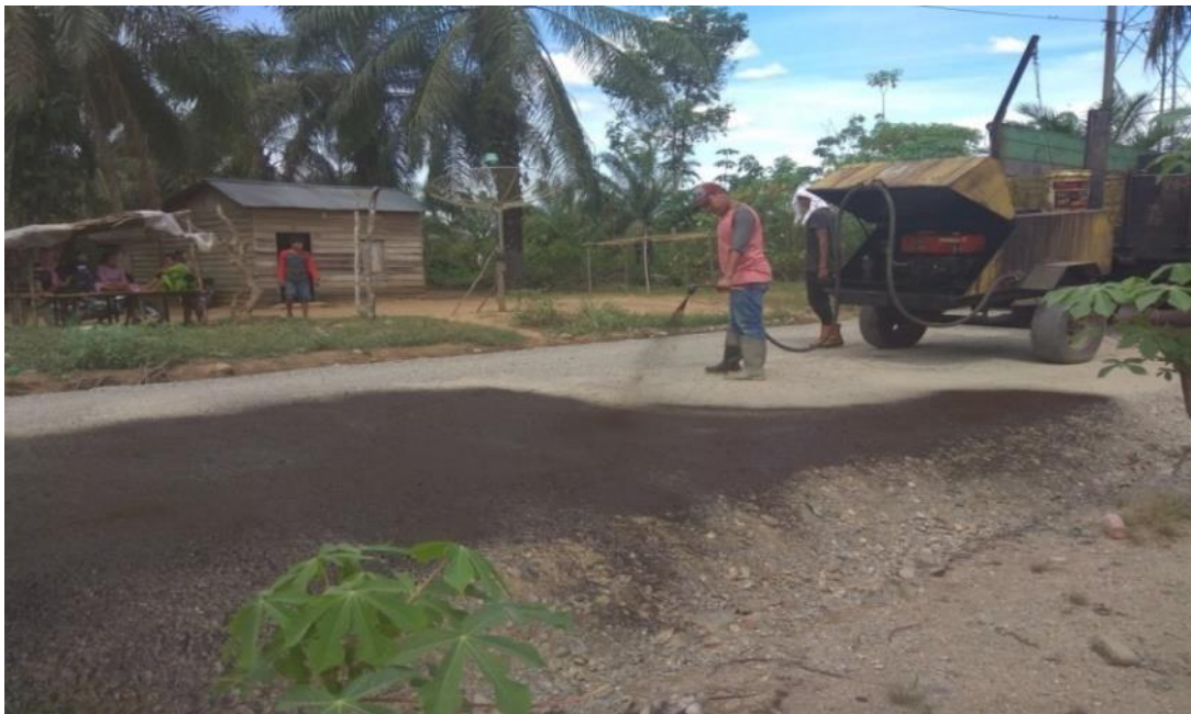
Gambar 8: Penyiraman Tack coat sebagai perekat untuk aspal yang akan di hamparkan di lokasi kerja
