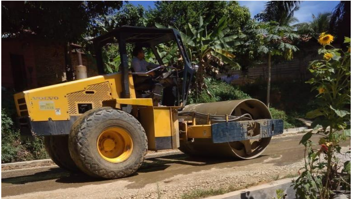
Gambar 1: Vibrator Roller saat sedang melakukan pekerjaan pemadatan bass AC WC
