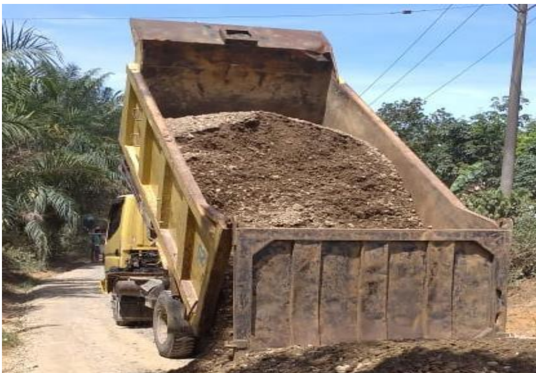
Gambar 4: Dump Truk saat melakukan penambahan bahan di lokasi kerja
