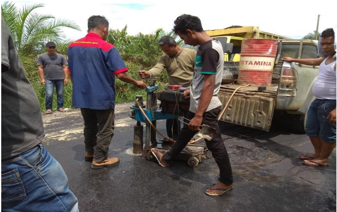
Gambar 11 : Melakukan Test Core untuk mengecek apakah sudah pas ketebalan aspal di lokasi kerja
