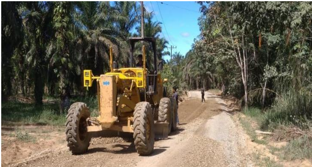
Gambar 2: Motor Grader saat melakukan penghamparan bahan di lokasi kerja
