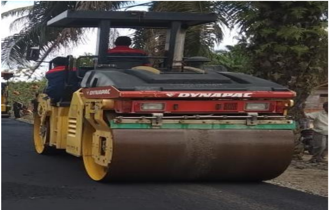
Gambar 5: Tandem Roller saat melakukan pekerjaan pengilasan aspal AC WC
