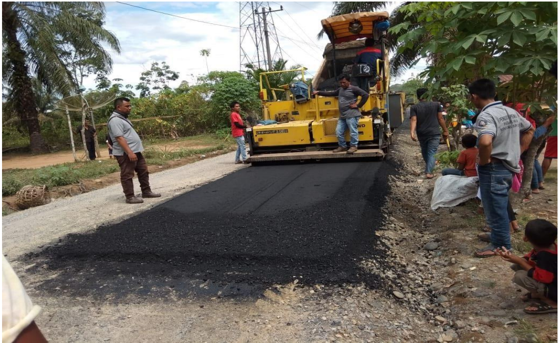
Gambar 7: Asphalt Finisher saat melakukan pekerjaan penghamparan aspal AC
