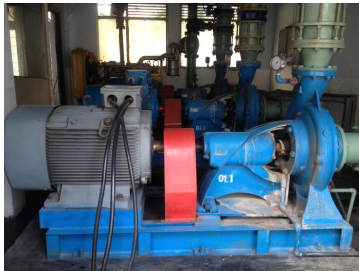
Gambar. 3.2. Motor Induksi terhubung dengan pompa sentrifugal
