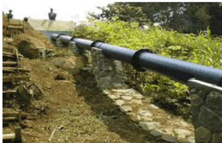
Gambar 2.5 Saluran pembawa ( Headrace )
