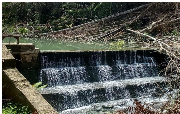
Gambar 2.3 Bendungan (weir) PLTMH
