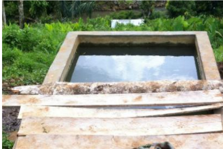
Gambar 2.6 Bak Penenang ( Forebay )
