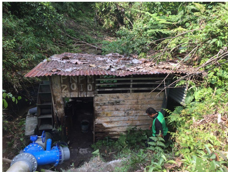
Gambar 2.2 PLTMH di Desa Rumah Sumbul
