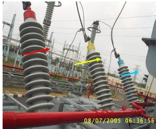
Gambar 2.7 Bushing pada transformator
