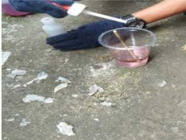
Gambar. 3.29 Menuang katalis kedalam wadah berisi resin
