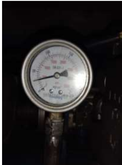
Gambar 4.19 Tekanan fluida pada pengujian kedua
