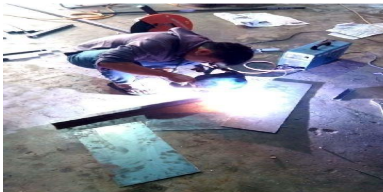
Gambar 3.26 pengelasan pelat untuk kotak panel
