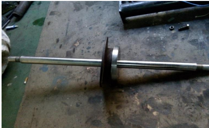
Gambar 3.23. Pemasangan Flange dan Piringan
