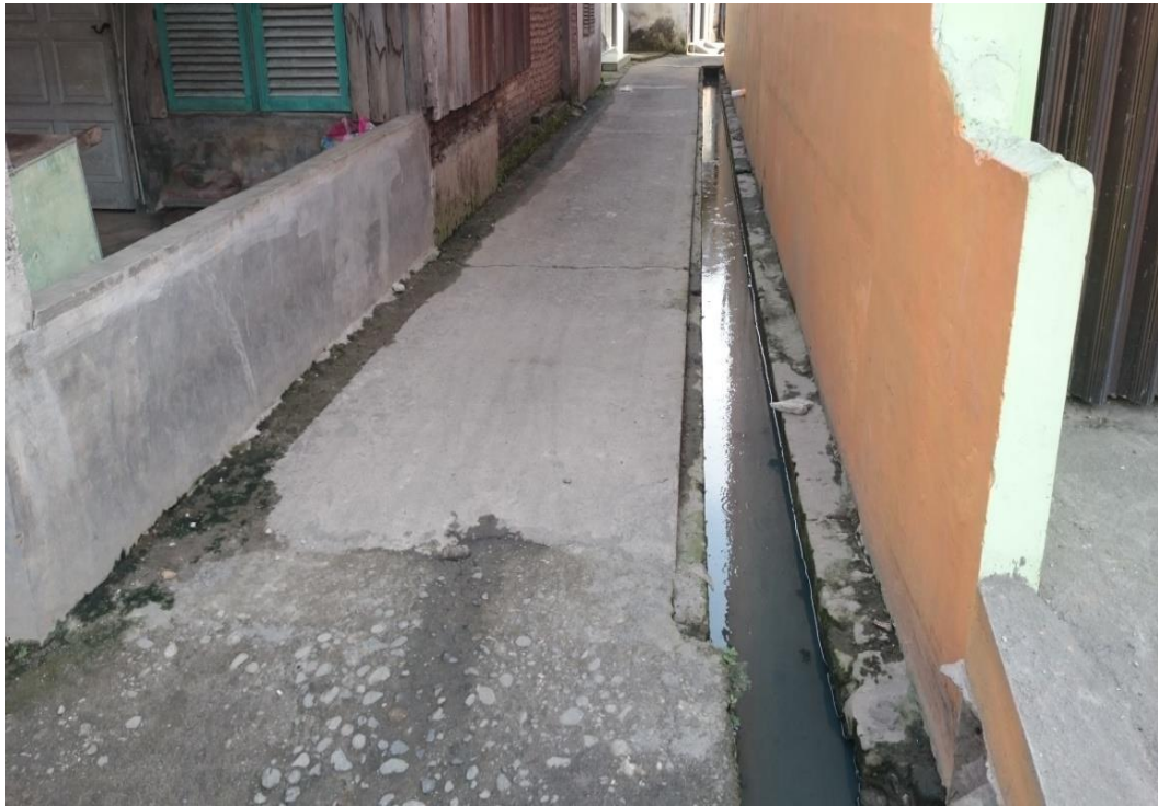
Kondisi drainase tersier pada STO-3 jarak 275 meter.
