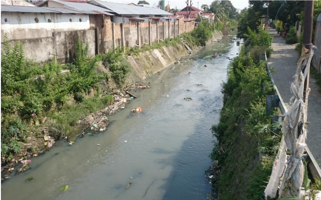
Kondisi drainase primer pada STO-3 jarak 402 meter.
