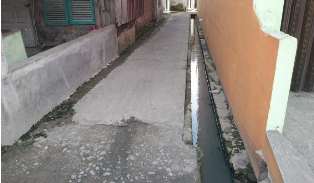
Gambar 3.9: Kondisi drainase tersier pada St-2 jarak 100 meter (Kanan).
