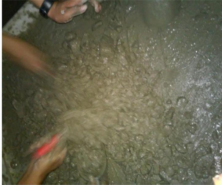
Gambar L7: Proses pencampuran agregat.
