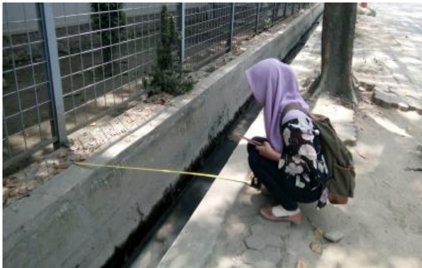
Gambar 3.8: Pengukuran dimensi penampang saluran drainase sebelah kanan di kawasan Jalan Jawa.
