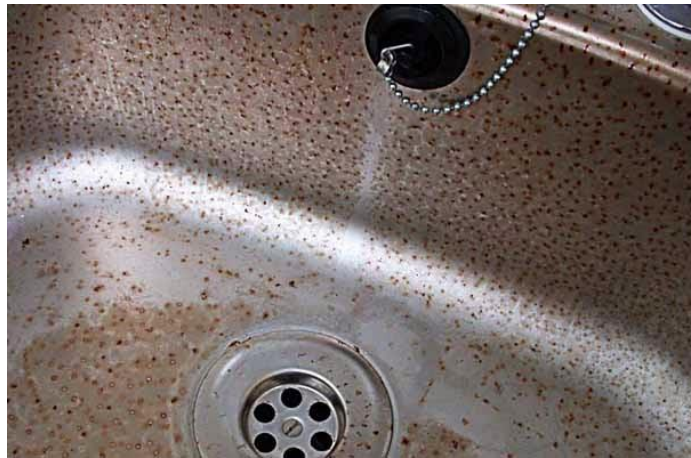
Gambar 2.5 korosi sumuran pada wastafel
