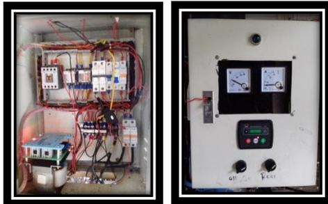
Gambar 3.7 Hasil pemasangan komponen sistem proteksi
