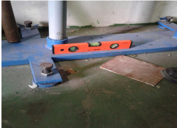
Gambar 3.15 Meratakan plat dukungan
