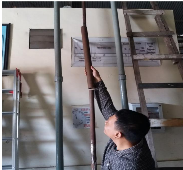
Gambar 3.16 Pemasangan Striker Bar
