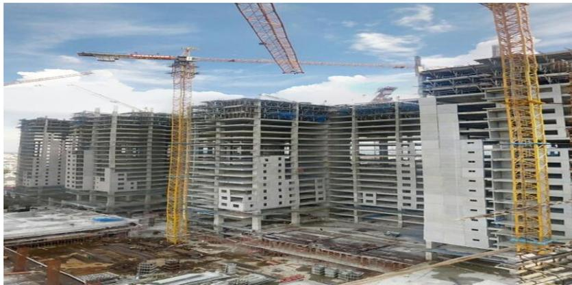
Gambar L.7: Lokasi dan pemasangan dinding *precast*
