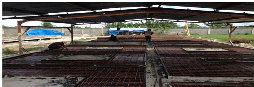
Gambar L.4: Pembesian produksi *precast*.
