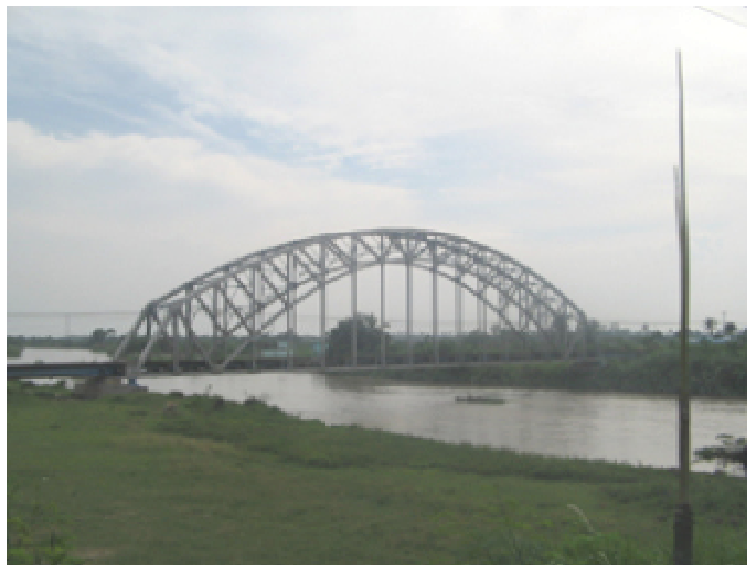
Gambar 2.1: Jembatan busur tiga sendi (jembatan sei ular).
