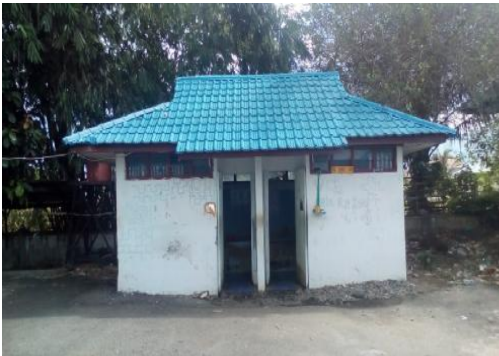
Gambar L. 8: Fasilitas Toilet di Terminal.
