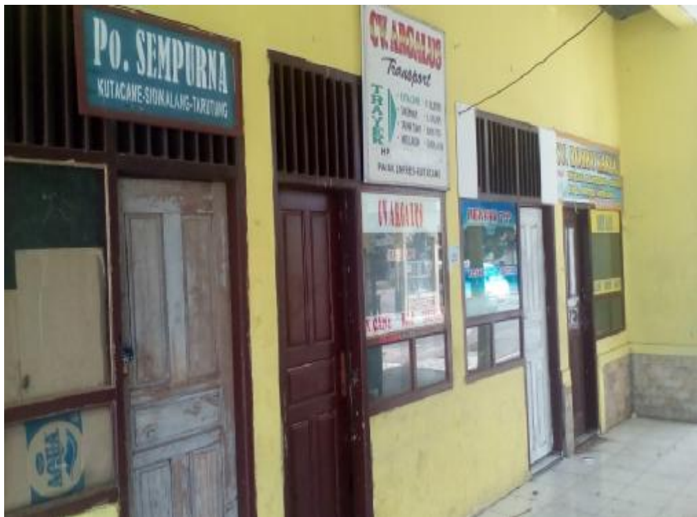
Gambar L. 4: Loket Karcis yang Tidak Berfungsi.
