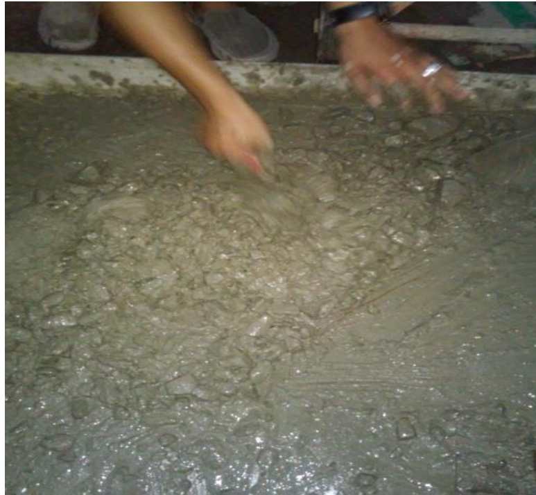
Gambar L5 : Proses pencampuran agregat
