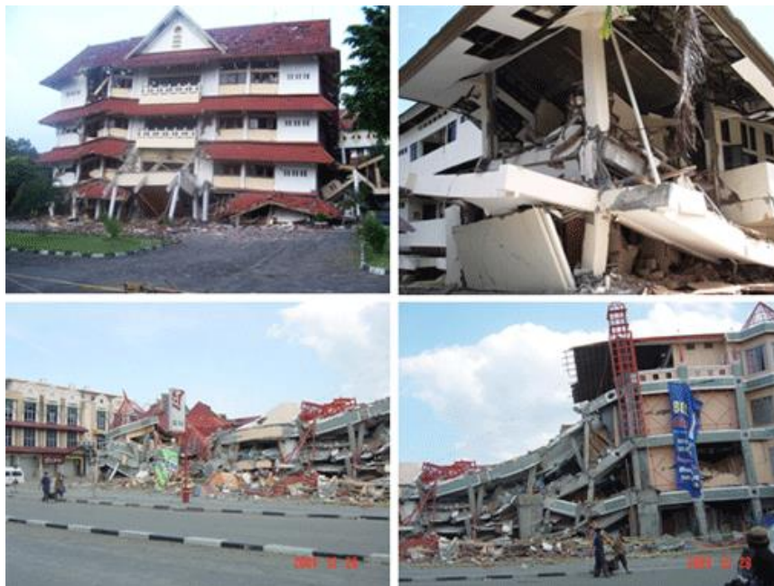
Gambar 2.3: Kerusakan struktur akibat terjadinya gempa bumi ( http://bmkg.go.id/dampak_gempa2 ).
