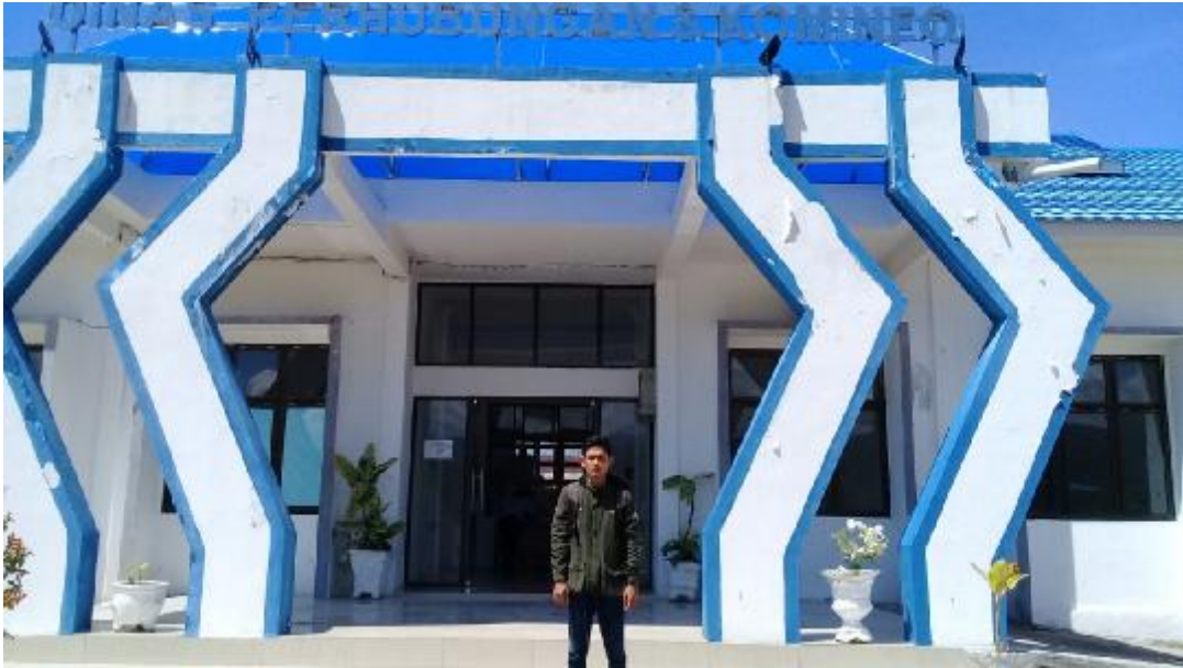
Gambar L.13 Bangunan Kantor Dinas Perhubungan Kabupaten Tapanuli Tengah.
