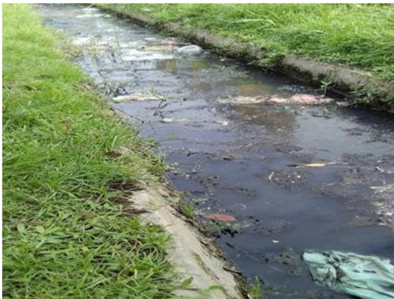
Gambar L6: Gambar kondisi saluran drainase sebelah kiri di Jalan Seroja.
