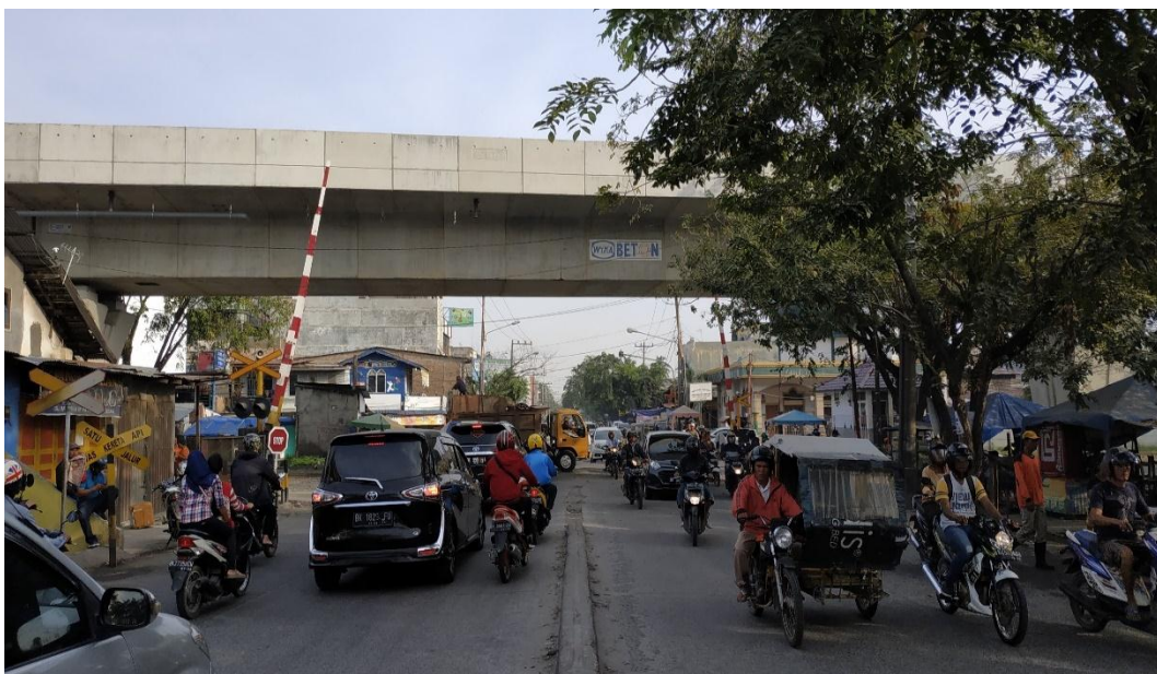
Gambar L.2: Perlintasan sebidang jalan rel dengan jalan raya pada ruas Jalan Mandala By Pass
