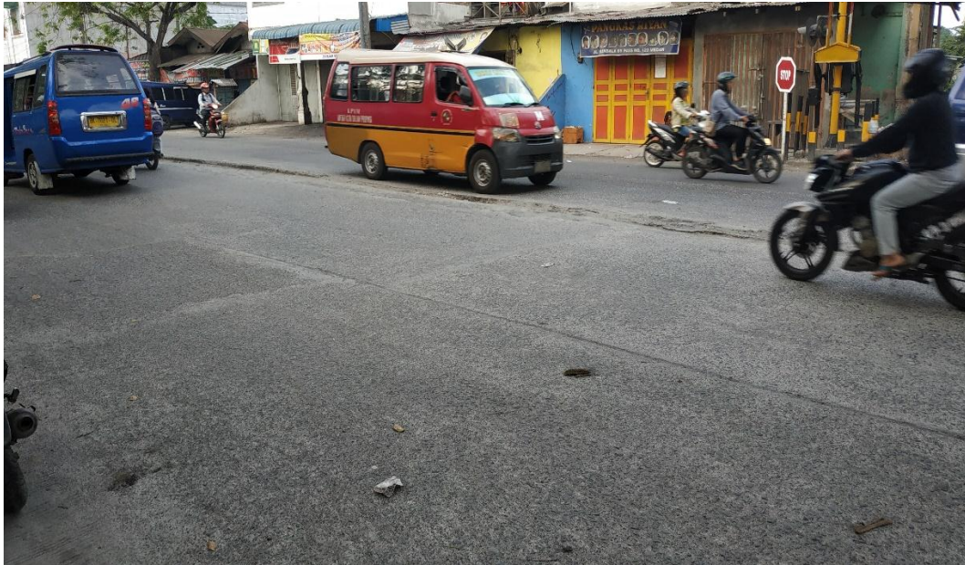
Gambar L.6: Kondisi marka membujur jalan pada titik persilangan antara jalan rel dengan jalan raya di ruas Jalan Mandala By Pass
