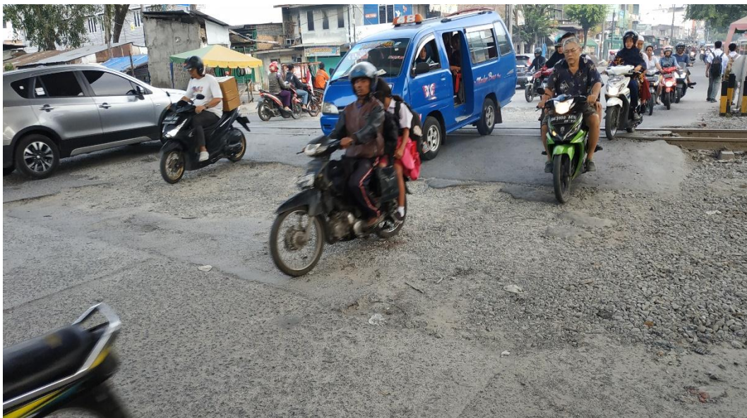
Gambar L.5: Kondisi geometri Jalan di perlintasan sebidang pada ruas Jalan Mandala By Pass terdapat banyak lubang-lubang
