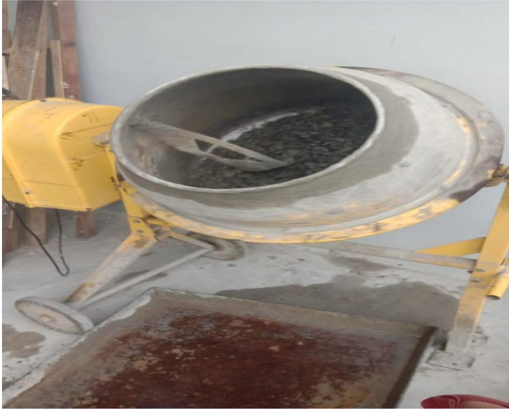
Gambar L9: Proses pembuatan beton menggunakan *mixer*.
