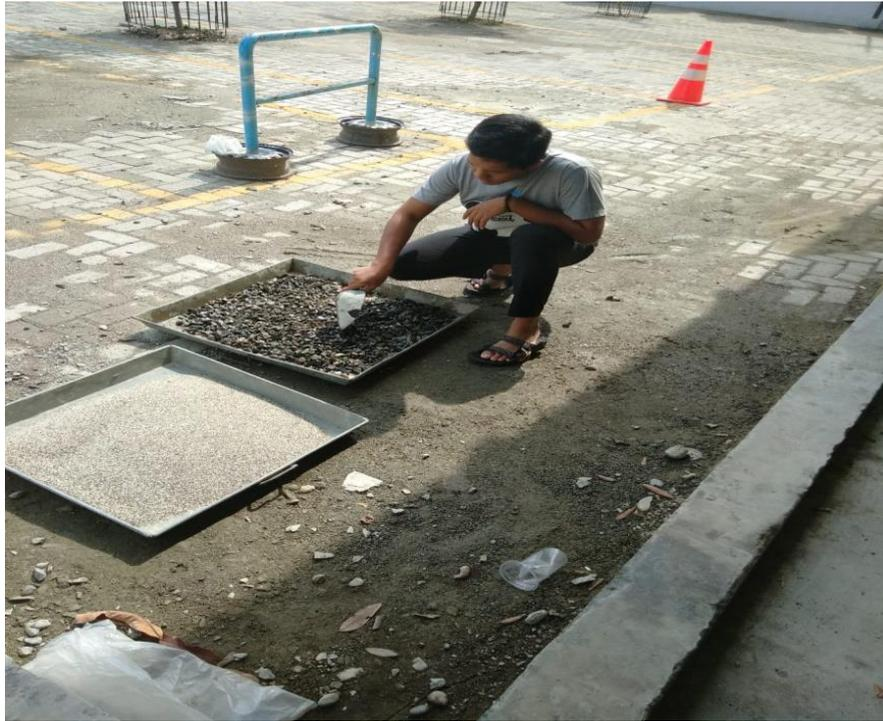
Gambar L3: Penjemuran agregat yang akan digunakan.
