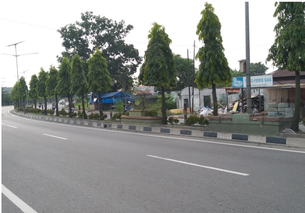
Gambar L.5: Titik survei tikungan keempat. Terlihat jelas banyaknya bangunan yang menutupi daerah kebebasan samping yang mengakibatkan rawan kecelakaan
