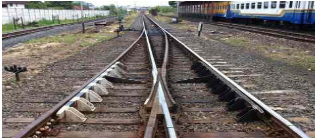
Gambar 2.10: Wesel (Peraturan Menteri Perhubungan Republik Indonesia nomor: KM 31 tahun 2011).
