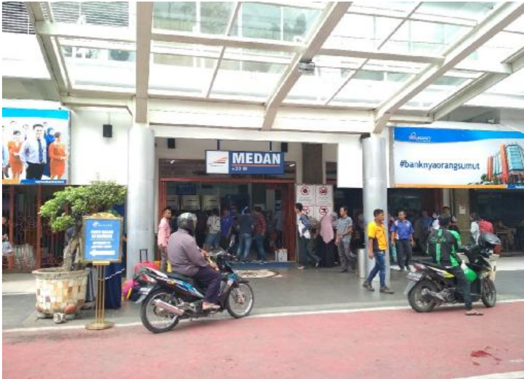
Gambar L7: Pintu masuk stasiun kereta api.
