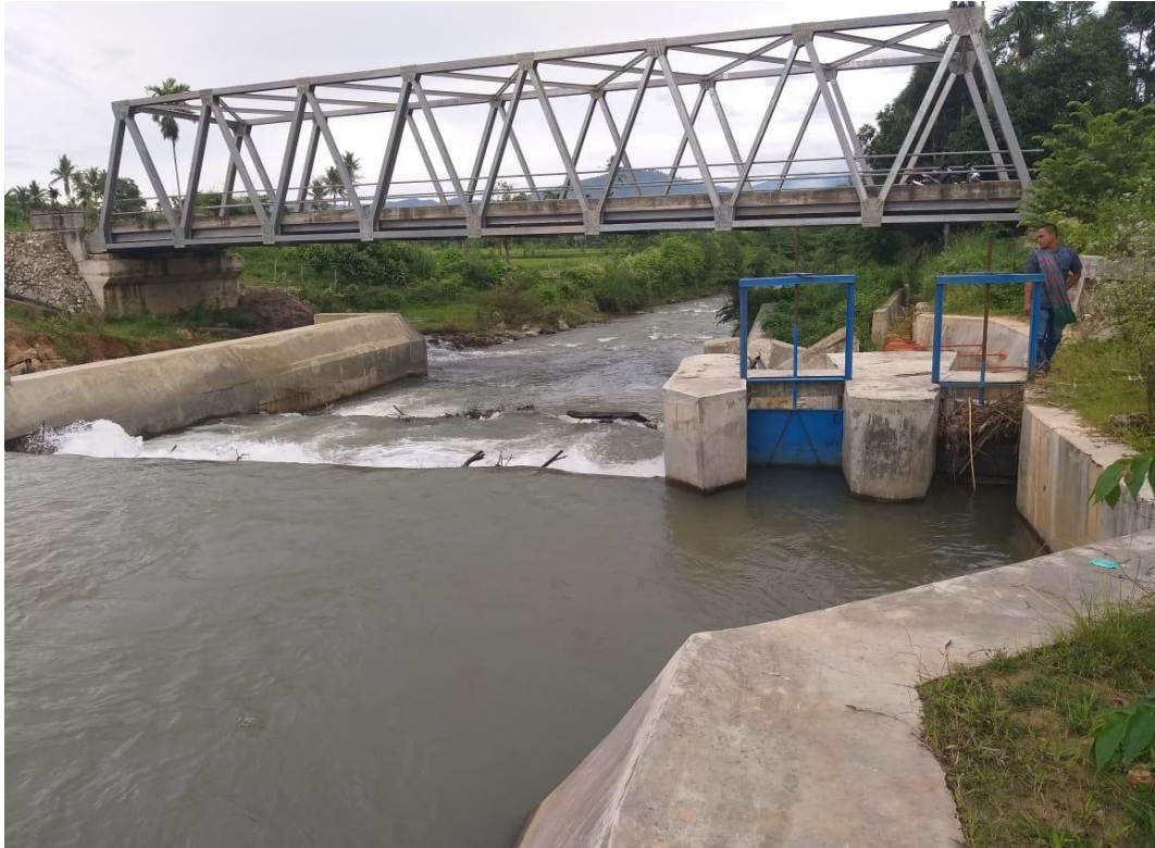
Gambar L3: Pintu Pengambil dan Pintu Penguras.
