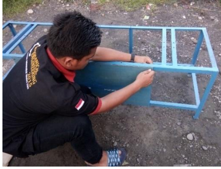
Gambar 3.23 Memasang Triplek
