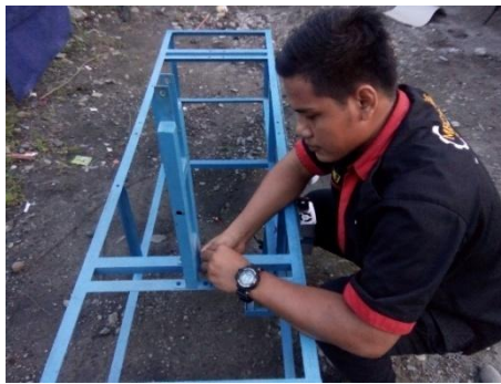
Gambar 3.24 Memasang Tiang Panel
