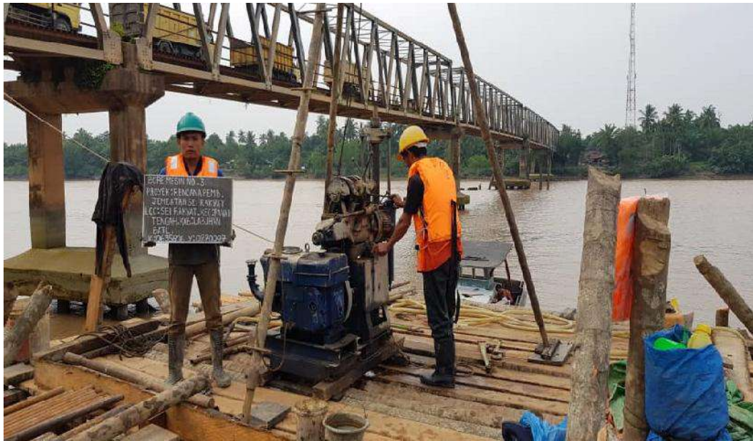
Gambar 3.13. Pelaksanaan pengeboran dengan bor Mesin di jembatan Sei Rakyat
