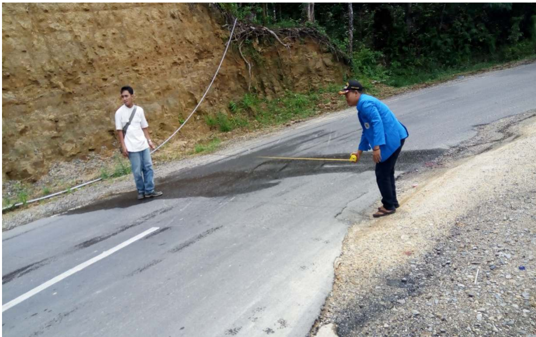
Pengecekan Lokasi 4 M Menadi 7 M bersama TEAM Konsultan Supervisi
