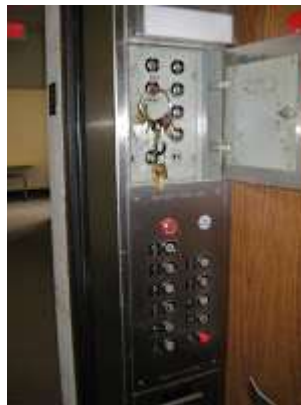
Gambar 3.16. COP dan Switching Box
