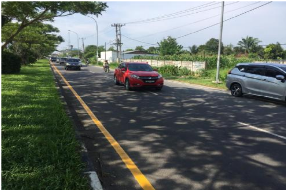
Gambar L2: Kondisi jalan arteri primer menuju kualanamu
