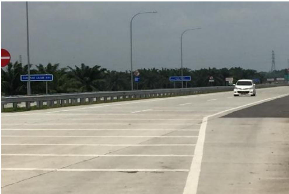
Gambar L4: Kondisi jalan tol Tg. Morawa menuju kualanamu
