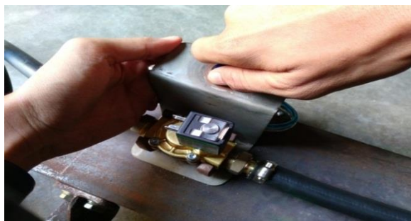
Gambar 3.14 Pemasangan tombol switch
