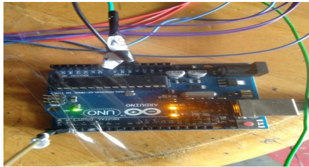
Gambar 3.19 Pemasangan Sensor Dallas
