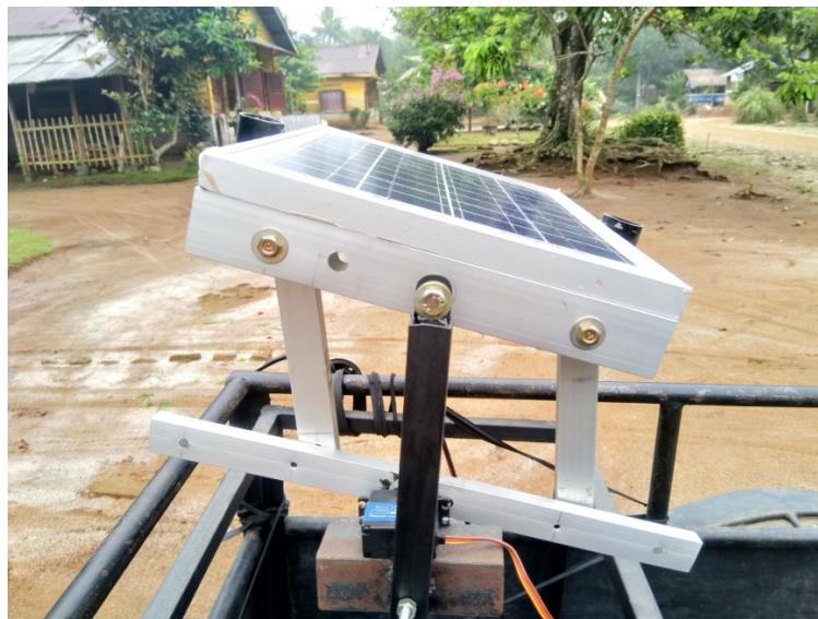
Gambar 4.12. Posisi panel surya pada pukul 14:00 WIB
