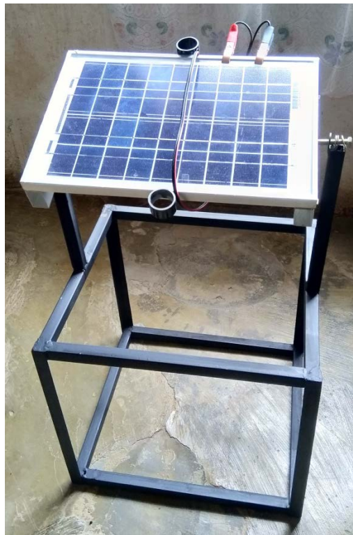
Gambar 3.29. Pemasangan panel surya
