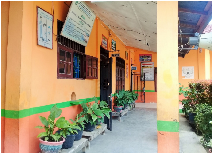
Foto Kantor dan Pengolahan Data Siswa SD Pembangunan Bagan Batu, Riau.
